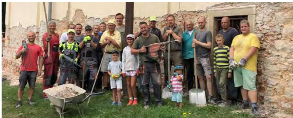
Farníci a občané odstranili část vnější omítky poškozenou vlhkostí.
