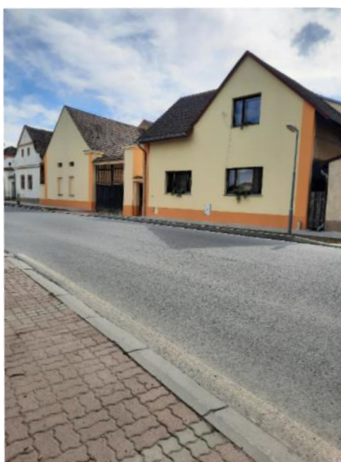
bývalá zemědělská usedlost č.p.27
