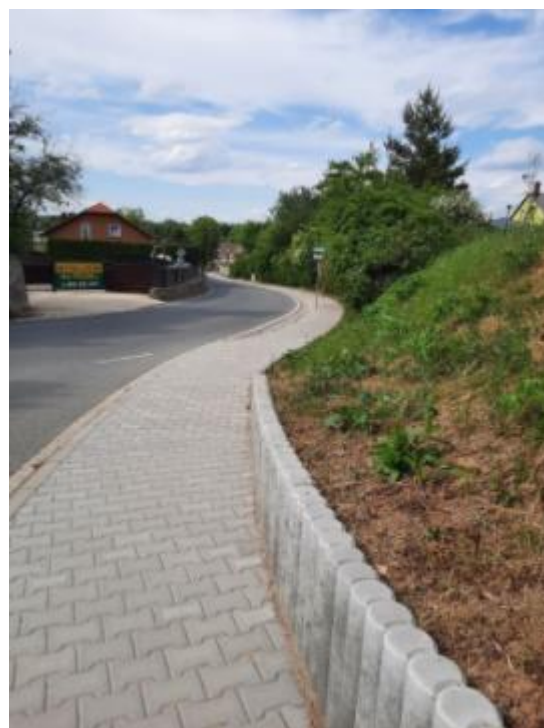
nově zřízený chodník se ladně vine kolem Karlštejnské ulice k Mlýnské ulici
