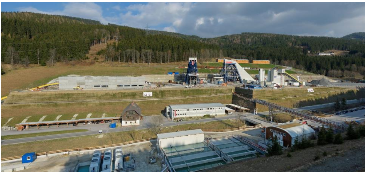
Obrázek 3.2 – Zařízení staveniště, Brenner Base Tunnel, zdroj: ÖBB
