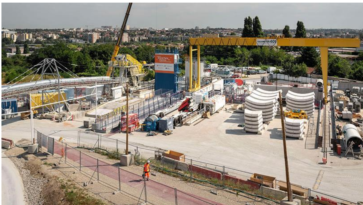
Obrázek 3.3 – Zařízení stavenišť, Great Paris Express, zdroj: Greater Paris Society, Gérard Rollando
