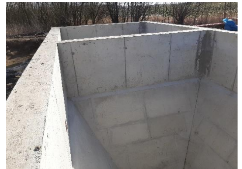
Betonáž nových nádrží je téměř hotová
